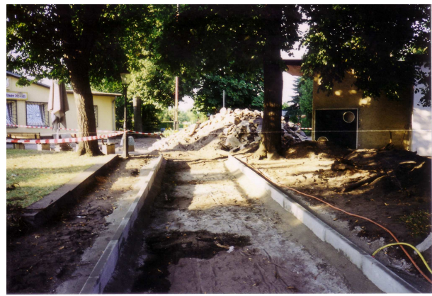
Nach dem Aushub wurden zunächst Kantensteine einbetoniert, damit der Weg nicht wegrutschen kann
