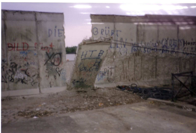
Abriss der Mauer am Dammweg
