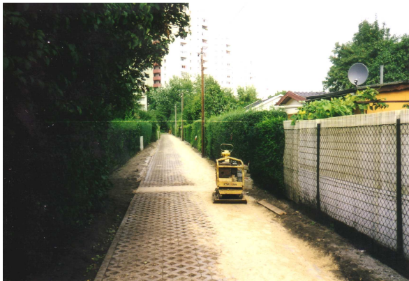
Kies auffüllen, Rasengitter- und Verbundsteine verlegen, alles fest rütteln - fertig!
